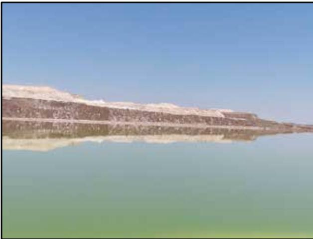
**Problema:** El área ocupada por las soluciones de purga del proceso de evaporación solar de soluciones triplica al área de diseño, por la dificultad de evaporar soluciones con concentraciones mayores a 600 g/L de sales totales disueltas (cinética y calidad de sales precipitadas), lo que se traduce en un 4% de menor disponibilidad de área, equivalente a 300.000 m<sup>2</sup>.
